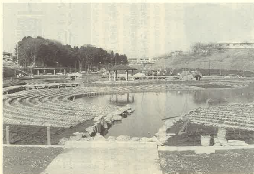
工業団地内に建設中の親水公園
