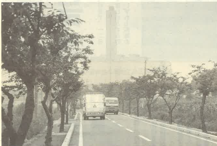
医療廃棄物が持ち込まれているおそれがある常総広域ゴミ処理場
