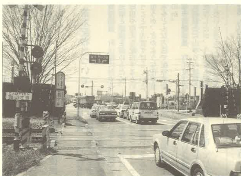
立体交差が望まれる愛宕踏切
