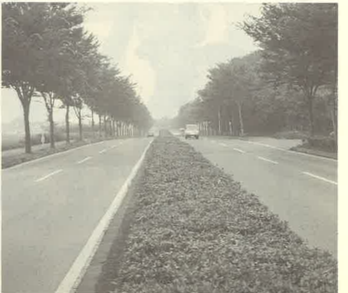
防犯灯の早期設置を(新守谷駅前通り板戸井地先)。
