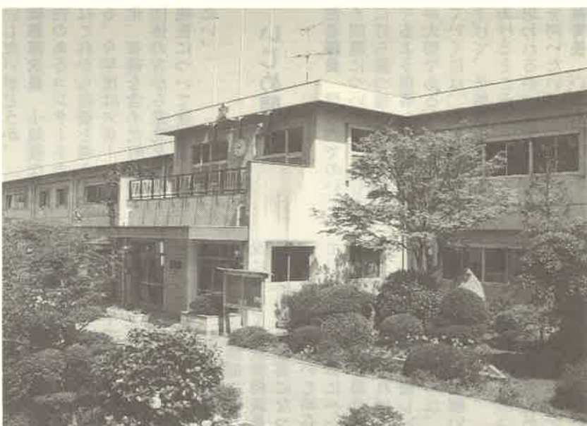
早期補修が待たれる高野小学校
