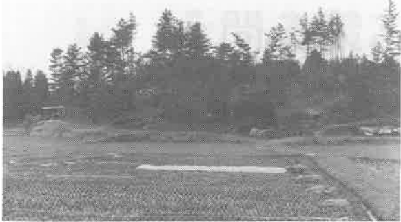
第2守谷小の建設予定地
