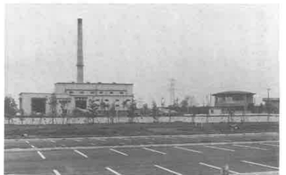
広域のゴミ処理場
