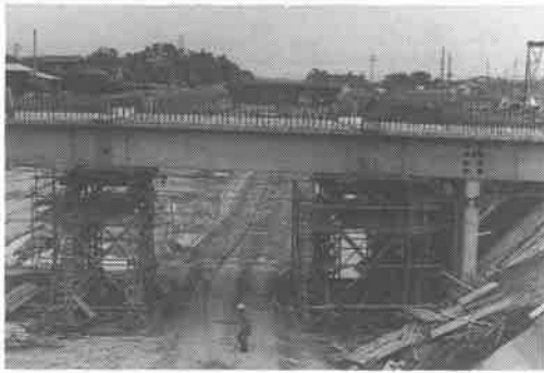
急ピッチで進められている高速道路工事
