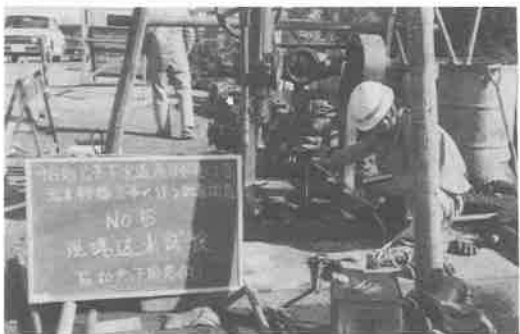
下水道幹線工事に伴う地質調査
