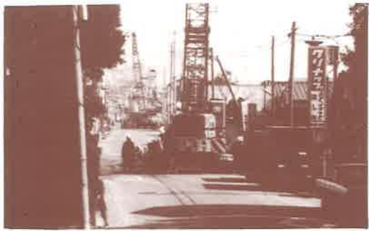
始まった下水道幹線工事(土塔)
