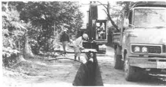
給水区域拡大に伴う水道工事（北園地内）
