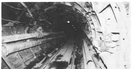
管渠工事も完成間近（写真は下水管内部）
