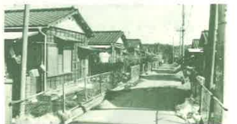
老朽化した町営住宅
