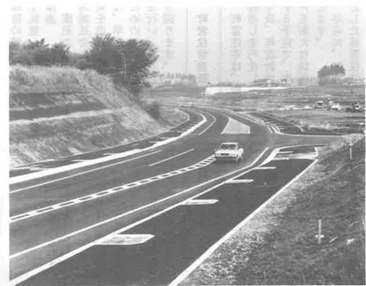
一部供用開始された取手西口—北守谷線 (本宿—大柏間)
