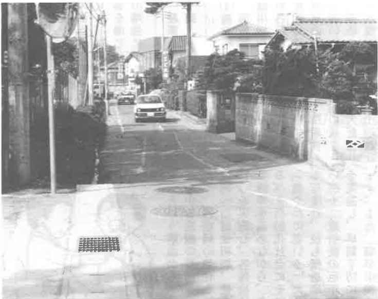
拡張が望まれる町道20号線 (やなぎ町地内)
