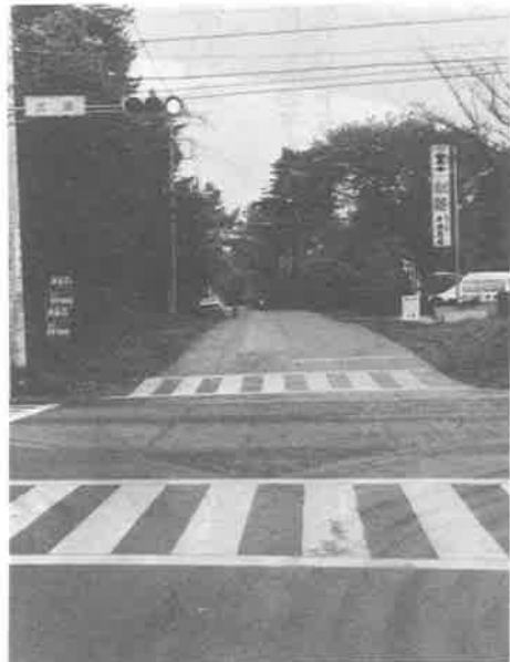
整備促進が望まれる北団・野木崎線
