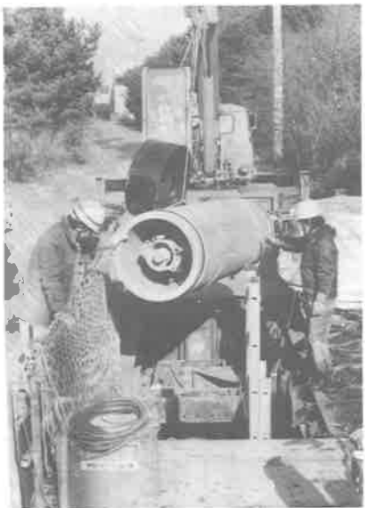
拡張工事が進む下水道事業(立澤地内)
