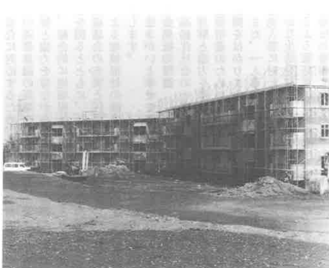
薬師台に建設中の町営住宅
