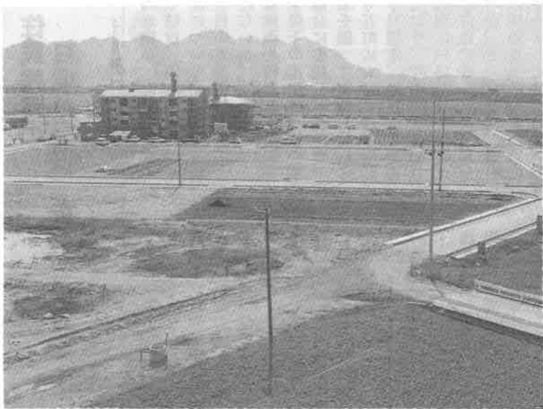
進行中の小郡駅南土地画整理事業
