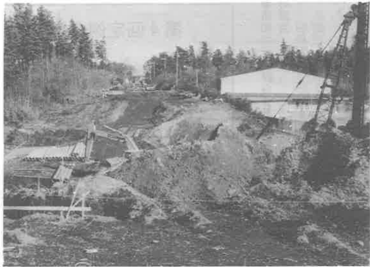
整備が進められる都市計画道路北園野木崎線
