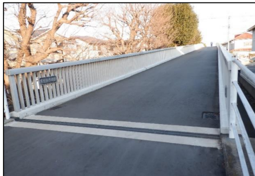
【施工例】 修繕工事が完了した素住台歩道橋
