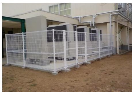
体育館空調設備設置工事の室外
