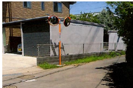
カーブミラー設置
