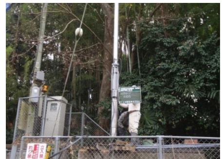
ポンプ更新工事 (長寿命化事業活動)
