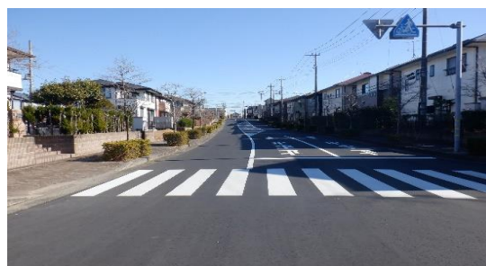
舗装工事が完了した市道4596号線(美園)
