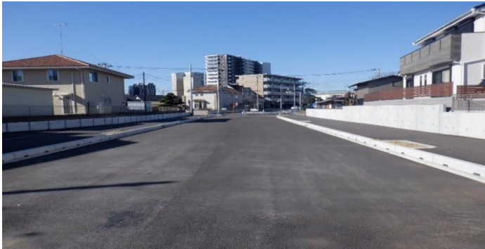
【施工例】 一部整備が完了したみずき野大日線(本町)
