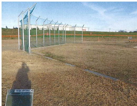
【施工例】大利根運動公園野球場移設工事
