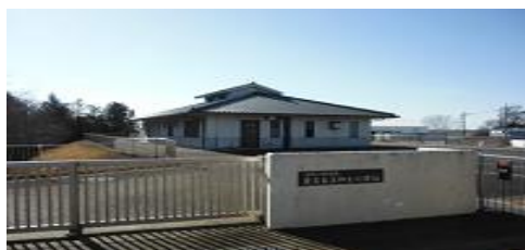
西板戸井地区 農業集落排水処理場
