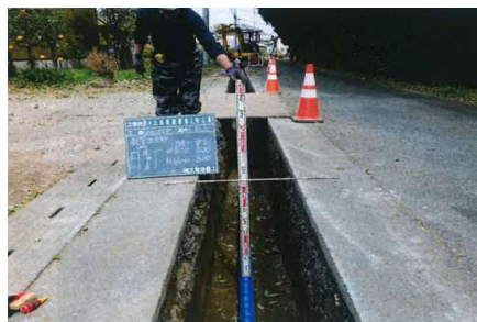
配水管布設替工事
