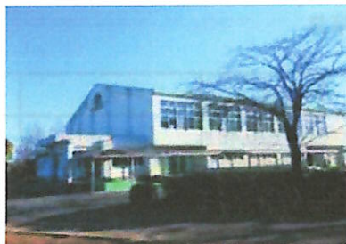
大井沢小学校屋内運動場外観
