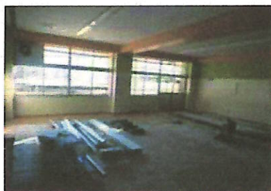
御所ヶ丘中学校内装改修工事の様子
