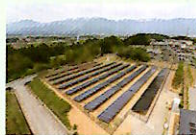
リユース品を使用した発電所
