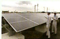
太陽発電設備の検査の様子
