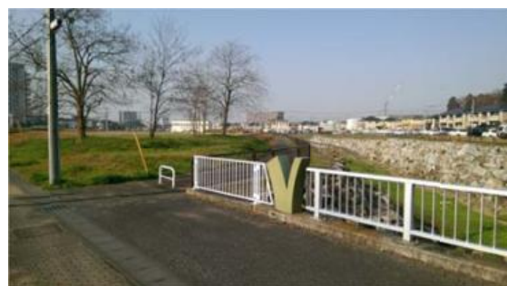
現況写真②（2015 年 12 月 16 日撮影）
