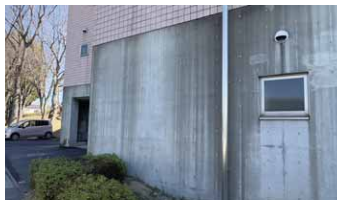
外壁コンクリート
