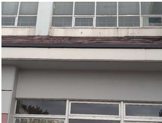
外壁や屋根に劣化が見られる。ところどころにクラックが生じている。
