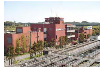
守谷浄化センター
