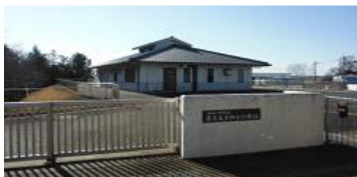
西板戸井地区 農業集落排水処理場
