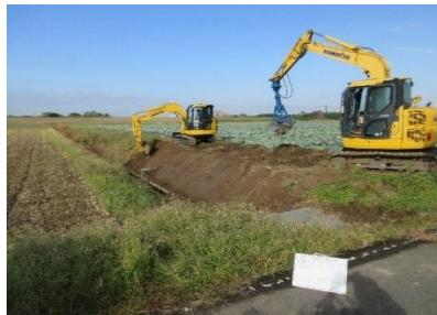
農用地法面補修
