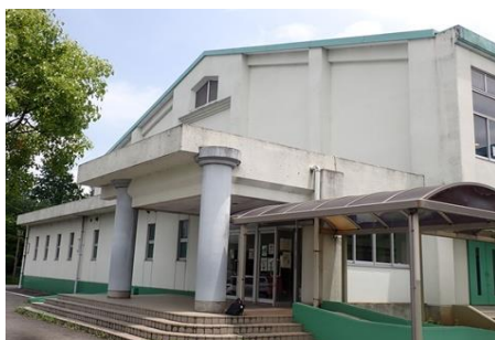
大井沢小学校屋内運動場外観
