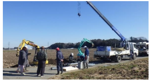
パイプライン付帯施設工事
