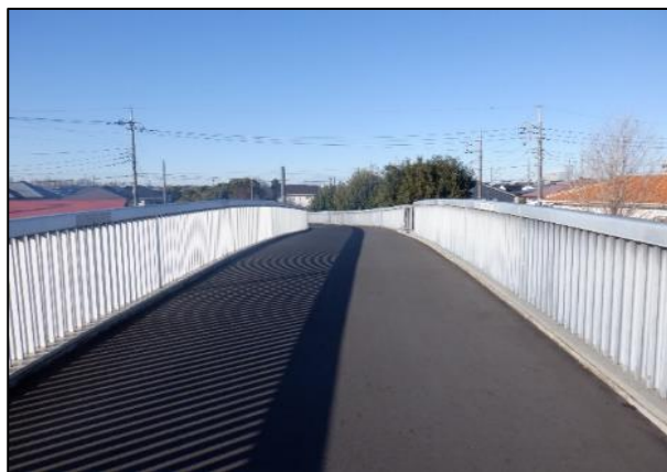
【施工例】修繕工事が完了した後田歩道橋
