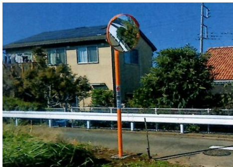
カーブミラー設置
