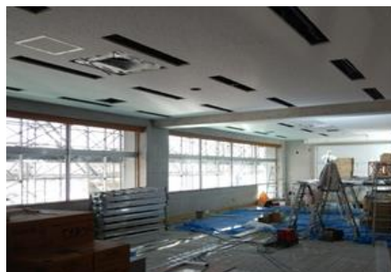
校舎内教室 工事状況
