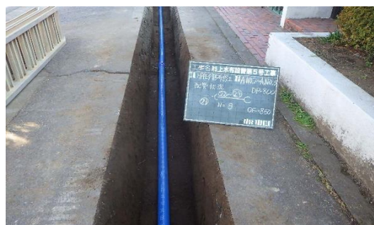
配水管布設替工事
