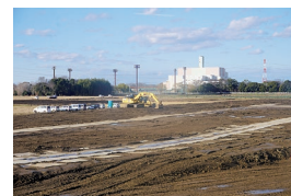
市側部分の盛土工事
