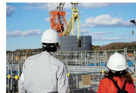
球場部分の工事状況
