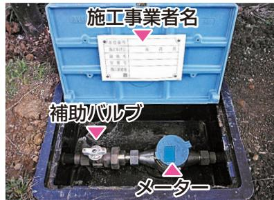
②メーターBOXのふたを開けてメーターのパイロット（銀色の羽根車）の動きを見る。
