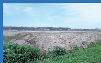
盛土工事の現況
