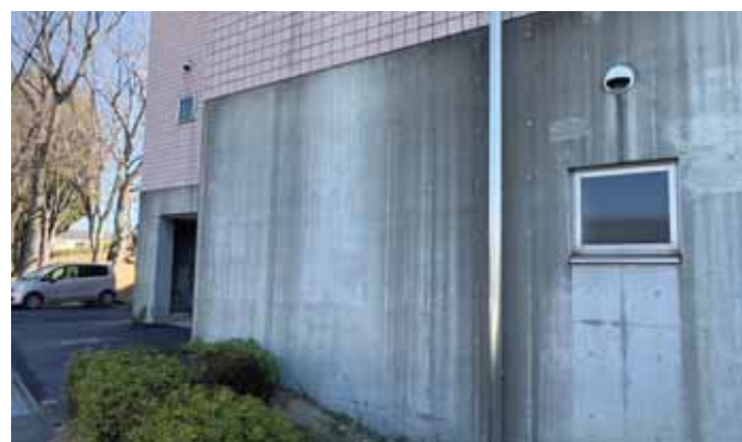
外壁コンクリート
