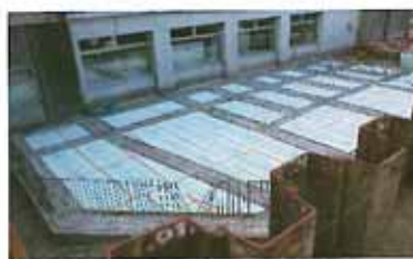
増築棟基礎工事
