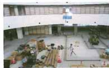
改修中の一般フロア
