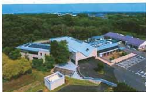
改修後の北守谷公民館
