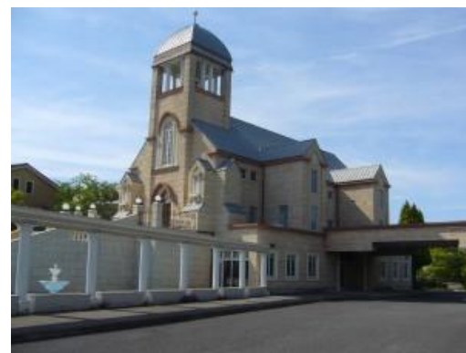
改修する旧結婚式場
