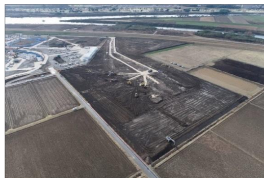
プレロード盛土工事
