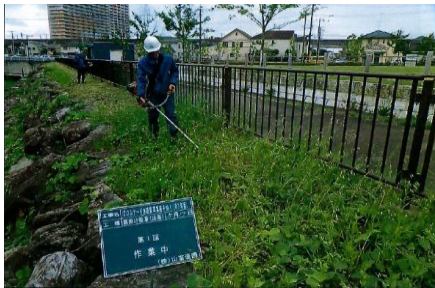
【施工例】プロムナード水路除草 施工中
