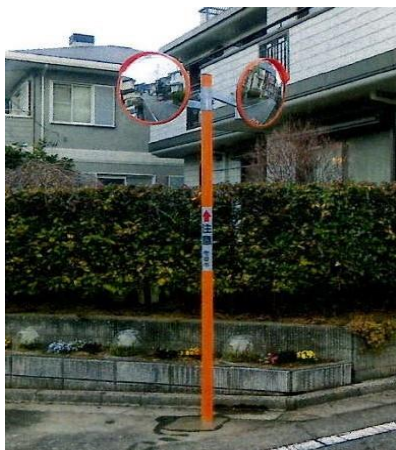
カーブミラー設置
