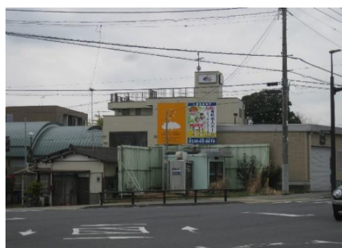
屋外広告物是正後
