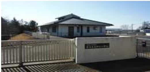
西板戸井地区 農業集落排水処理場
