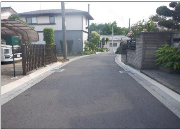
【施工例】道路改良が完了した市道3195号線(本町)
