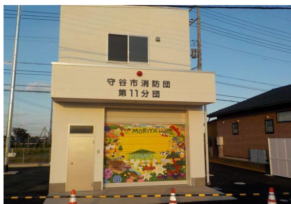
消防団機械器具置場兼詰所
