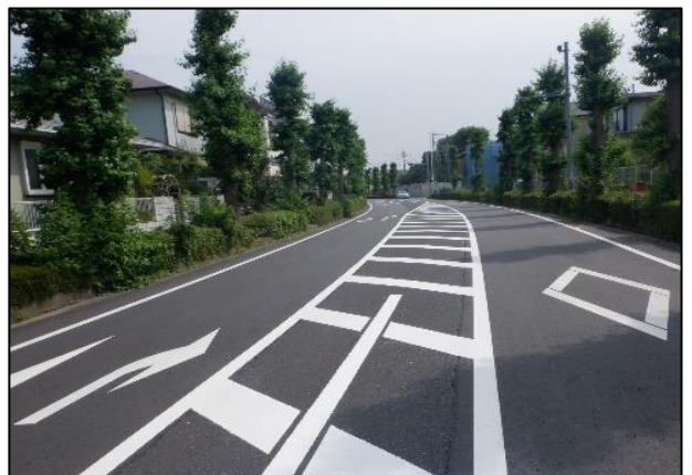
舗装修繕が完了した市道101号線(松前台)
