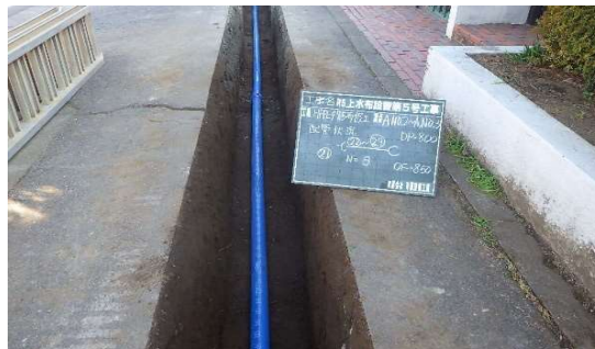
配水管布設替工事
