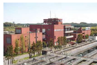
守谷浄化センター
