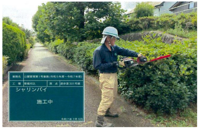
【施工例】公園寄せ植え刈込作業
