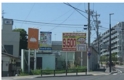
屋外広告物是正前
