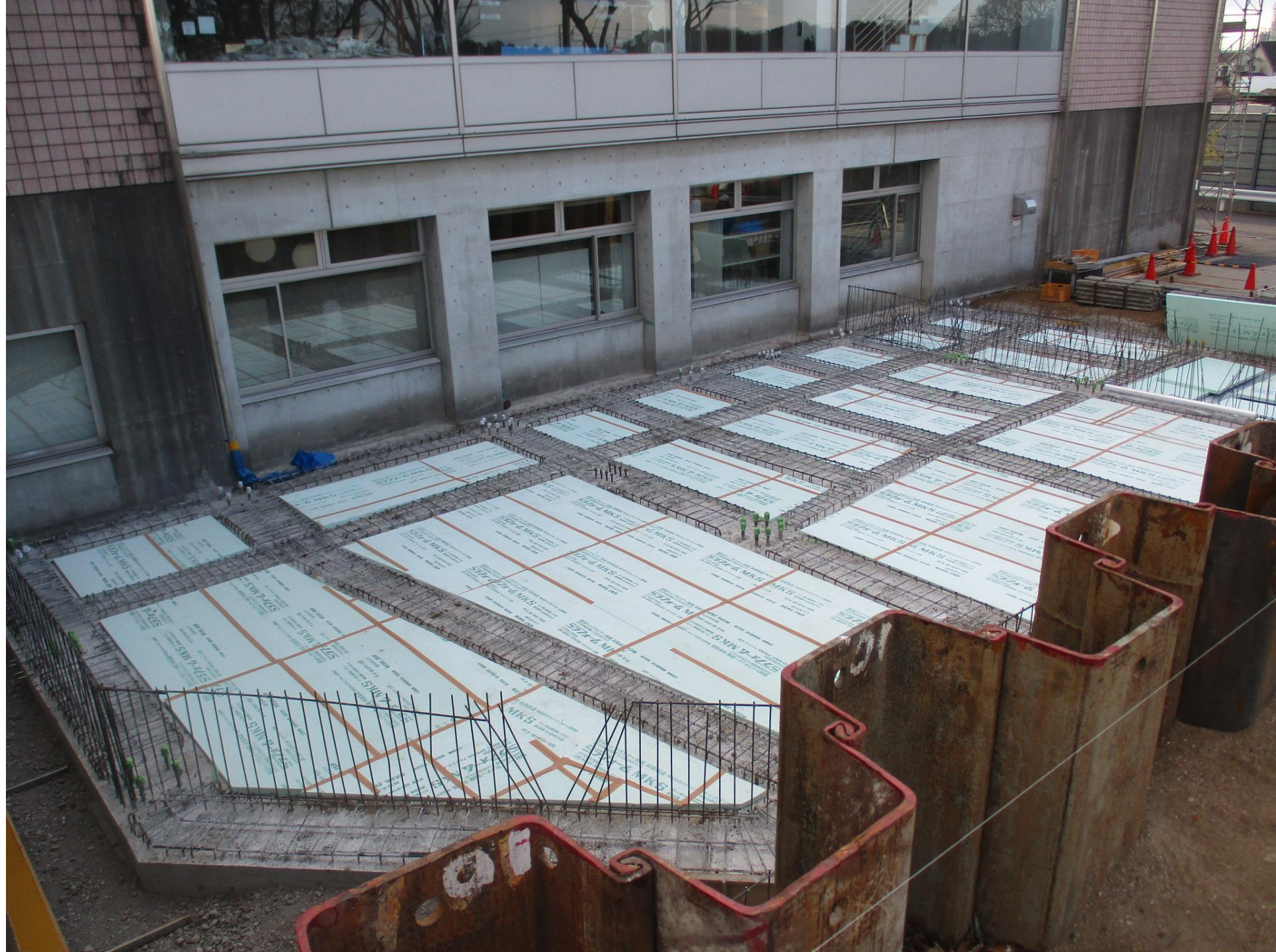
増築棟 基礎工事 1月
