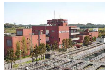
守谷浄化センター
