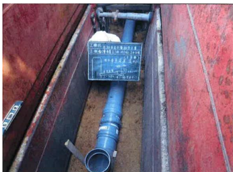
汚水管布設工事
