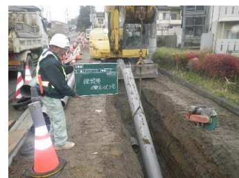
汚水管撤去状況
