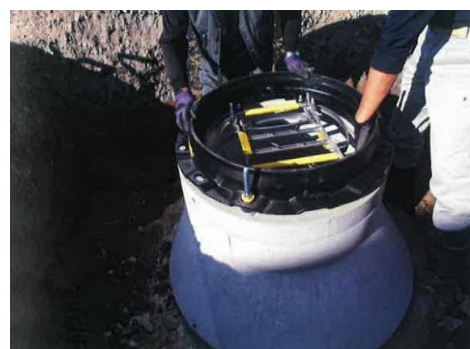
人孔鉄蓋更新工事
