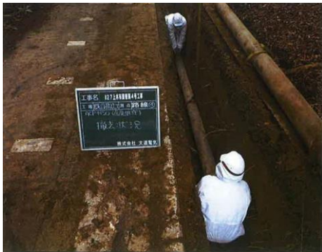
既設管撤去状況
