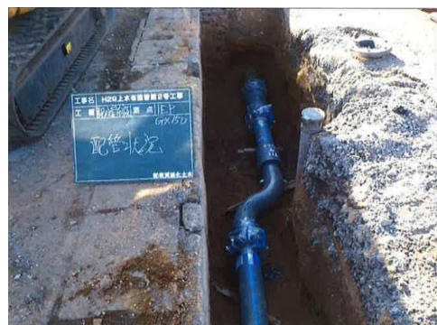
配水管布設替工事
