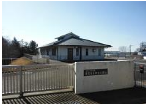
西板戸井地区 農業集落排水処理場
