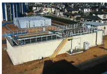
撤去予定浄水施設
