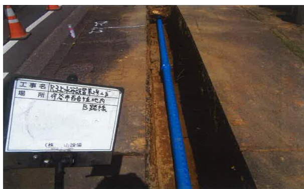
配水管布設替工事
