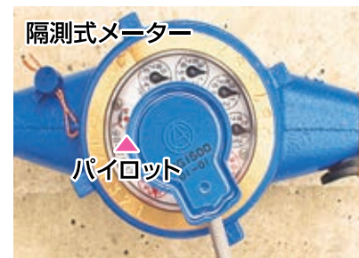
3 蛇口を全て閉めているのにパイロットが回る場合は漏水の可能性があります。（微量の漏水ではパイロットが1周するのに1～2分程度かかることがあります。）
