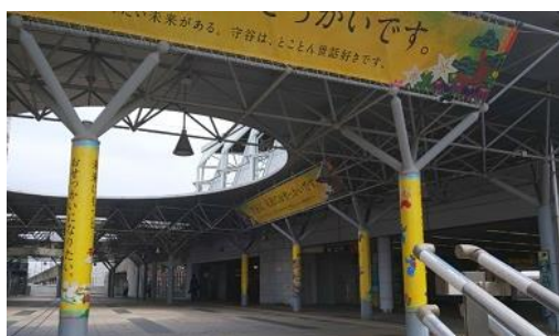
▲ 現在の設置状況
