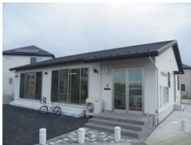
松並青葉西町内会集会所 （平成 27 年度建設）
