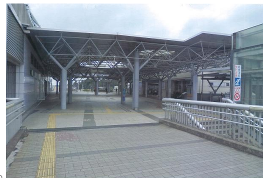
守谷駅自由通路
