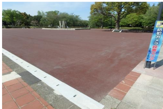
立沢公園園路カラー舗装
