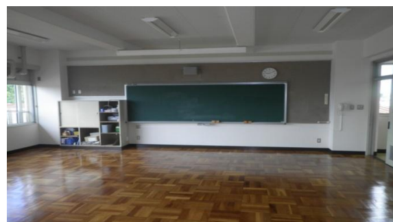
改修後の教室
