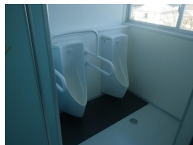
改修後のトイレ
