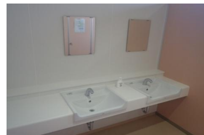
改修後のトイレ
