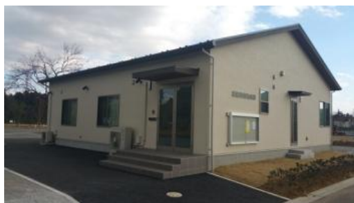
松並青葉東自治会館（新築）
